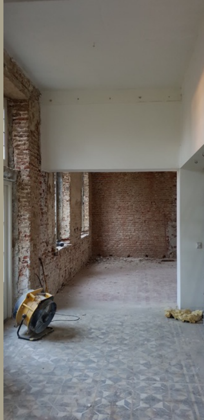
Verwijderen gipspleister
