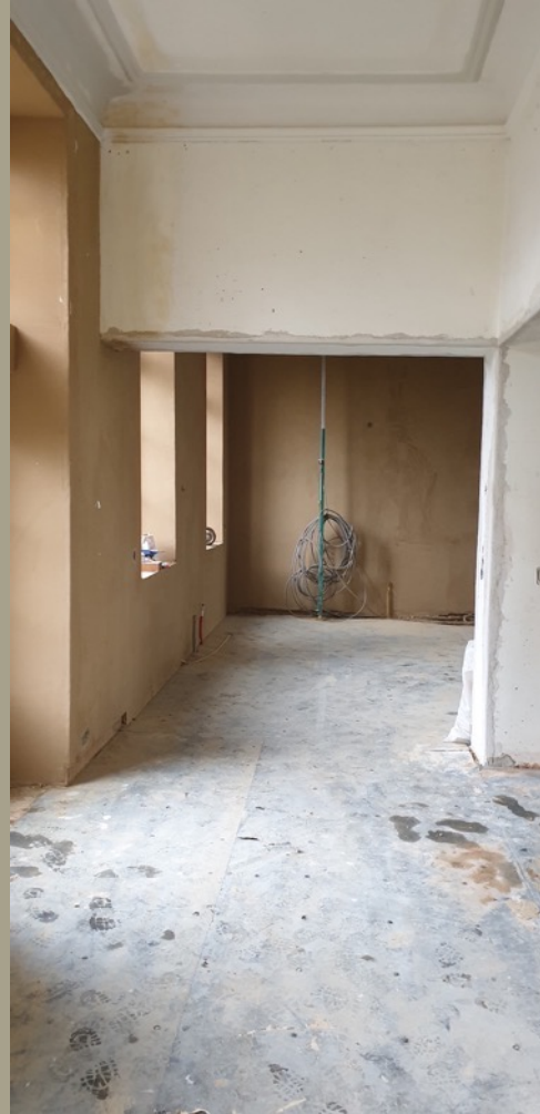
Uitvlaklaag / basislaag leem
