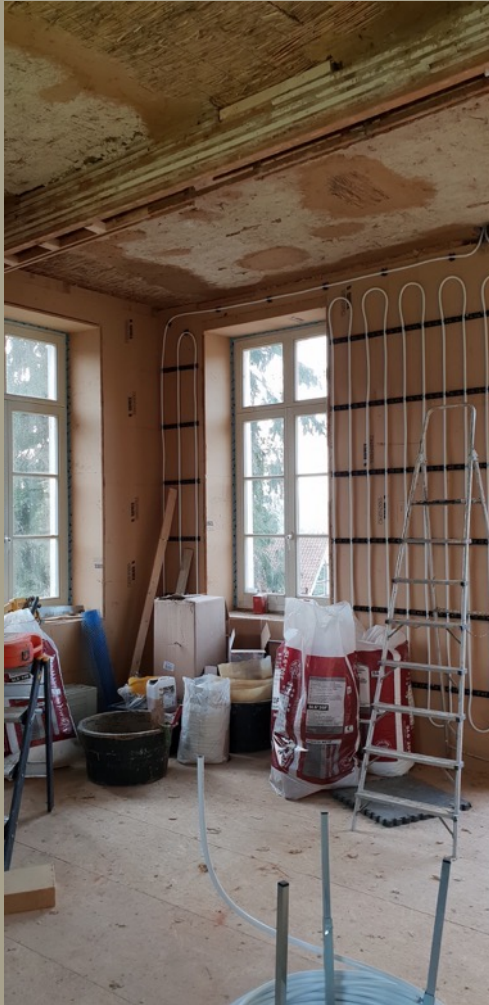
Aanbrengen wandverwarming
